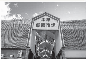
大阪木津卸売市場
